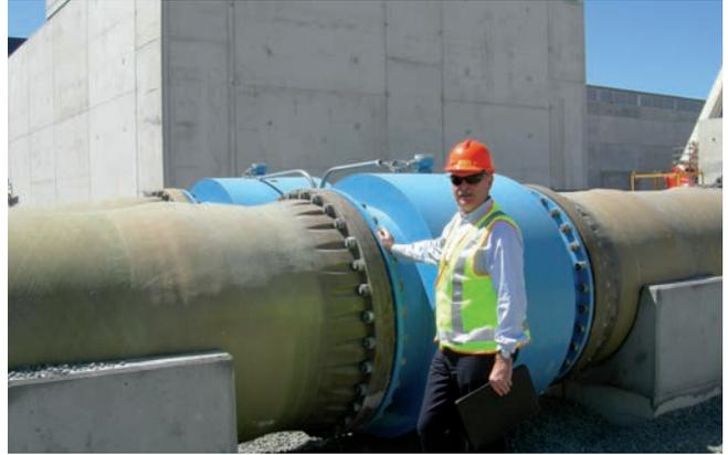
수많은 산업 부문에서의 전자식 유량계의 인기는 여전히 수그러들지 않고 있습니다. 이는 이 측정 원리가 60년 이상 전세계에서 애용되고 있다는 것을 증명하고 있습니다. 전자식 유량계는 용수, 폐수, 슬러지, 슬러리, 페이스트, 산, 알칼리, 주스 또는 과일 매시와 같은 고체 유무에 관계없이 5  $\mu\text{S}/\text{cm}$  이상의 모든 전기 전도성 액체를 측정하는데 사용될 수 있습니다.
